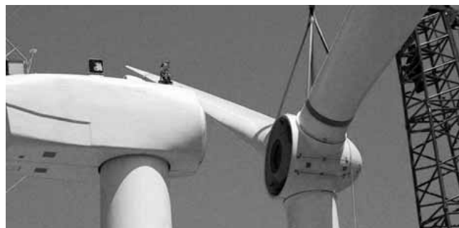
Figura 1, Montaggio dell’elica sulla navicella di una torre eolica, fonte immagine LIFEGATE, https://www.lifegate.it/cose-una-turbina-eolica
